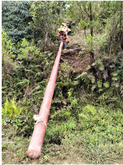
Gambar 1. Evakuasi material tiang JTR secara manual di medan Terjal distrik ibele
