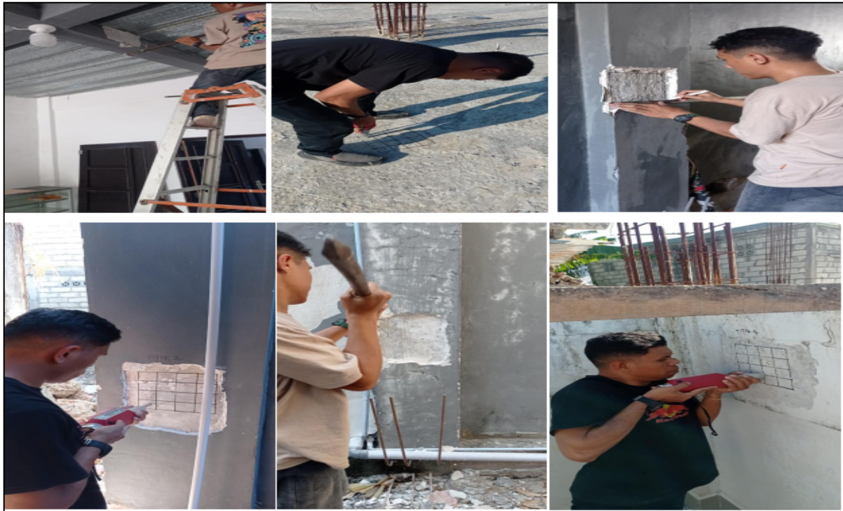
Gambar 4. Pengujian Hammer Test
